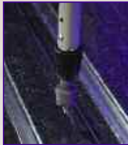
Perfore los orificios en la plataforma
