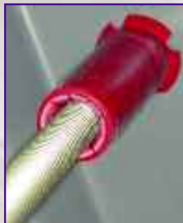
Vacíe el concreto y luego instale la varilla
