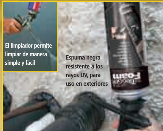
Rellena alrededor de las tuberías y conductos eléctricos
